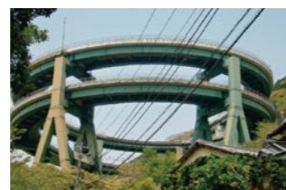
橋脚耐震補強整備事例
