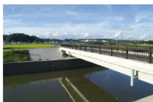
橋梁整備事例
