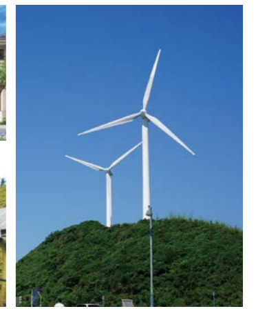
風力発電施設
