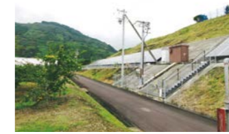
新丹谷太陽光発電施設
