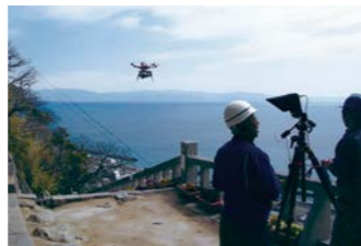
空中撮影を利用した石垣立面図の作成
