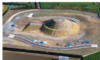
整備工事中の国史跡和田岡古墳群吉岡大塚古墳(静岡県掛川市)
