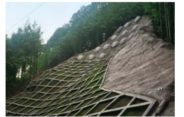
急傾斜地崩壊対策施設
