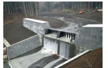
土石流に対応した砂防堰堤の改築
