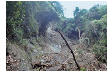
道路沿いの山腹斜面崩壊
