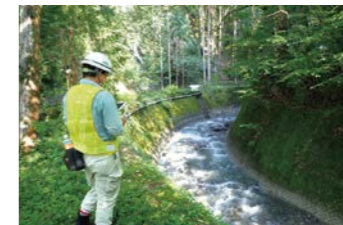
UAVを使った砂防施設点検
