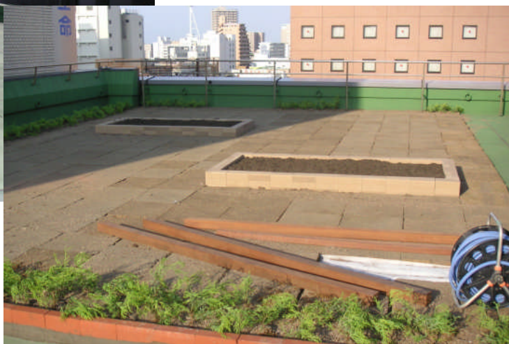
植栽基盤材敷設
