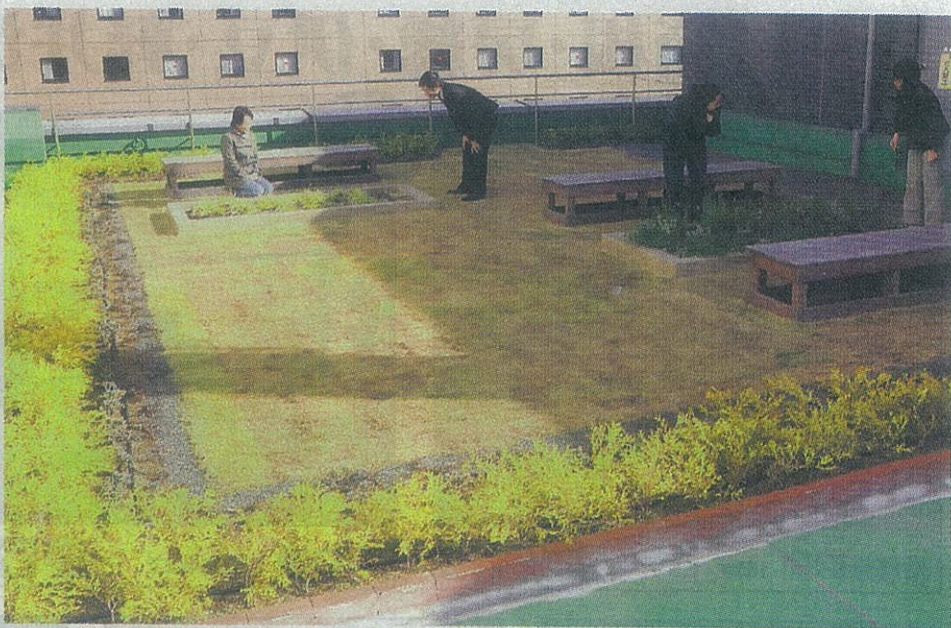
ビルの5階屋上に敷設されたモデル庭園。電気代節約に貢献し、景観上の効果も＝浜松市中区のフジヤマ
