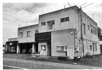
補強計画策定と実施設計は、飯尾建築設計事務所が担当。12月20日納期を進めている。
