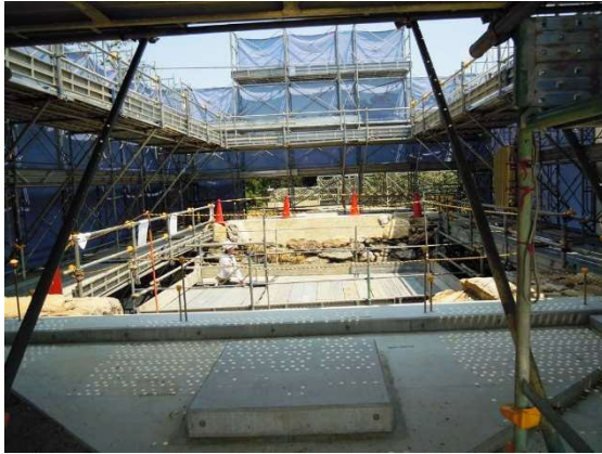
①天守門の建方用足場が設置されました。
