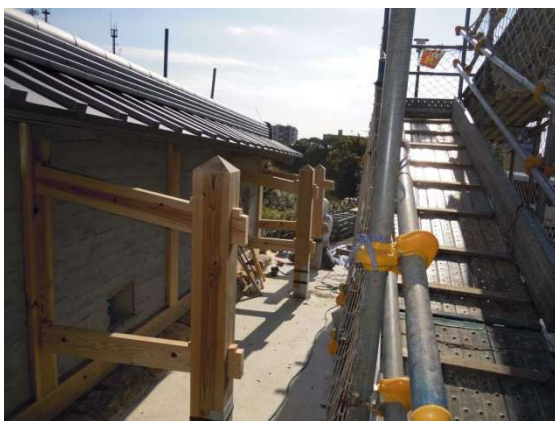
⑤塀瓦がのり、控え柱が設置されました。控え柱の足元は柱と石を相欠し、帯鉄で巻いています。
