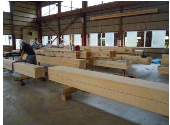
②木工事の作業場では、木材の加工が進んできました。
