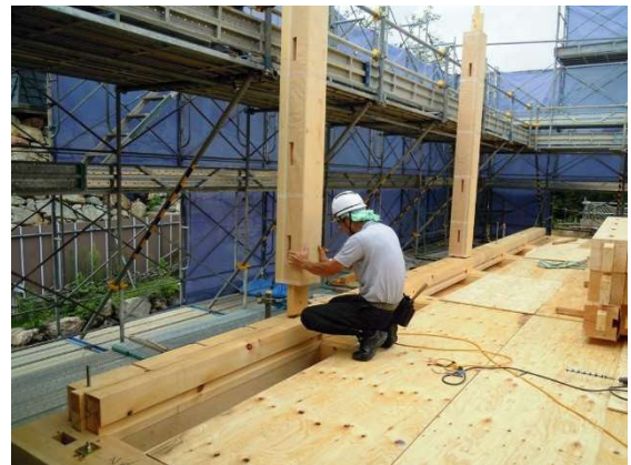
⑩檣の柱を柱盤に建て込んでいます。
