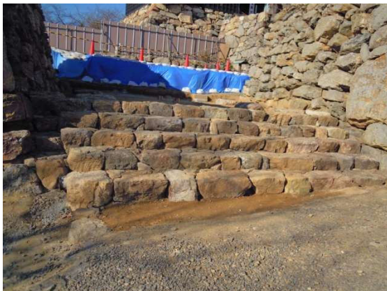
③明治時代以降に設置された石段を撤去し、浜名湖北部産の珪岩で新たに石段を設置しました。
