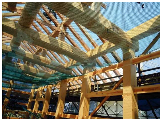
⑯檜の屋根の垂木をかけています。垂木は普通の住宅の柱ほどの太さがあります。
