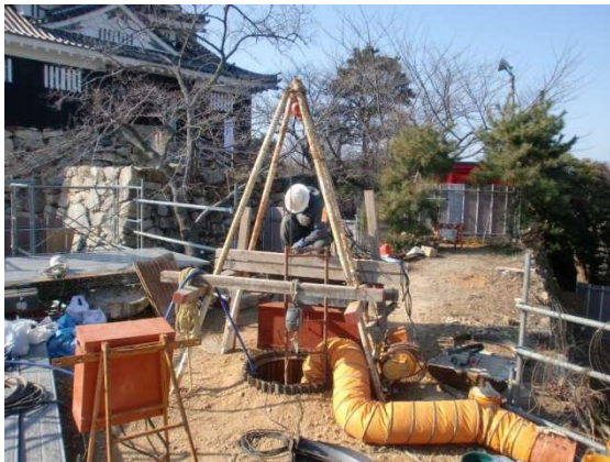
①いよいよ櫓の基礎工事です。両脇の石垣上に基礎の杭孔を掘るためのやぐらを設置しています。
