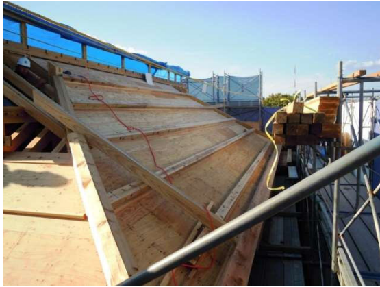
①屋根の下地と大棟の骨格ができてきました。
