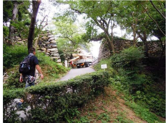
②7月22日、いよいよ天守曲輪西側の急坂から木材が現場に運び込まれます。天守台の石垣に当たらないよう、細心の注意を払ってトラックを運転しています。
