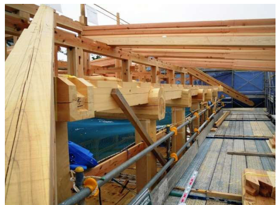
⑫野物の梁の上に軒桁が乗り、小屋の骨組みが組み上がってきました。
