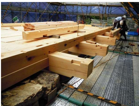
⑪床梁を持ち出して、門扉上の底を支える出桁をかけています。
