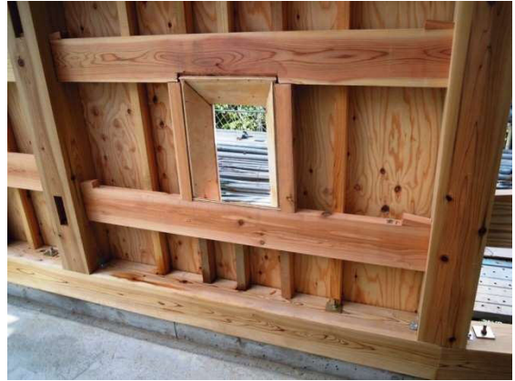
②土塀にあけられた矢狭間です。
