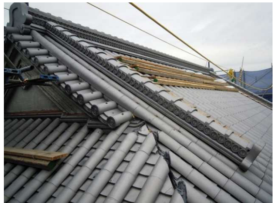
④屋根瓦葺きがだいぶ進んできました。
