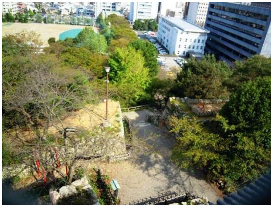
①工事前の様子、この石垣の切れ目に門を建築します。
