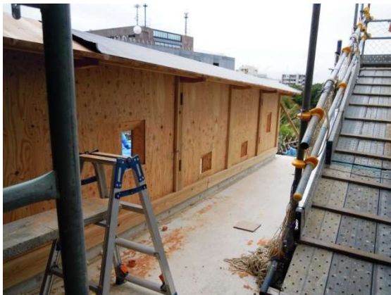
③土塀の下地ができてきました。この上に漆喰を塗ります。
