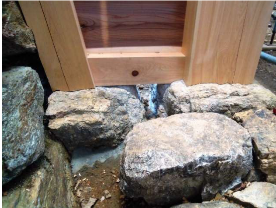
⑦門柱は全て礎石にひかりづけされています。礎石の間に排水用の隙間があげられています。
