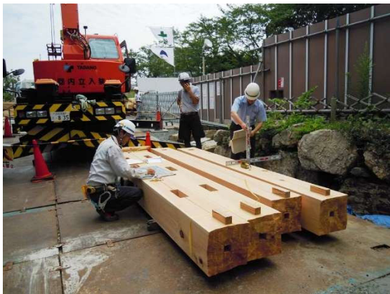
③門の控柱とダボの堅木です。門柱と礎石は江戸時代と同じように、ダボで接続されます。柱底面は、礎石の形状に合わせて削られています。
