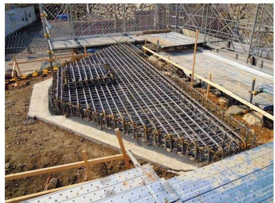
④杭の上部に建物の重さを支える耐圧版がのります。鉄筋を所狭しと並べ、ここにコンクリートを打ちます。
