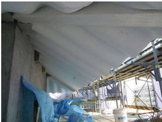
③ 屋根の軒裏を下から見上げた様子です。こちらも中塗りで、波型に塗り込めています。
