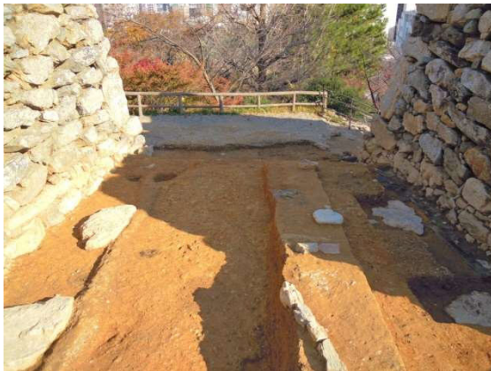
①石垣の間の地下を、門柱の礎石面まで掘りました。門の礎石や階段石周辺部を改めて調査しました。
