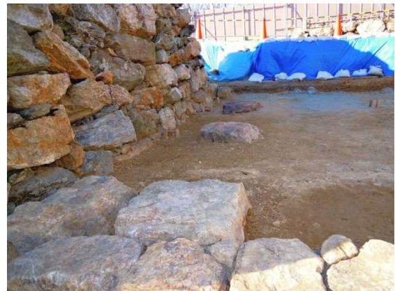
④古い礎石上に保護の盛土をして、新しい珪岩の礎石を設置しました。
