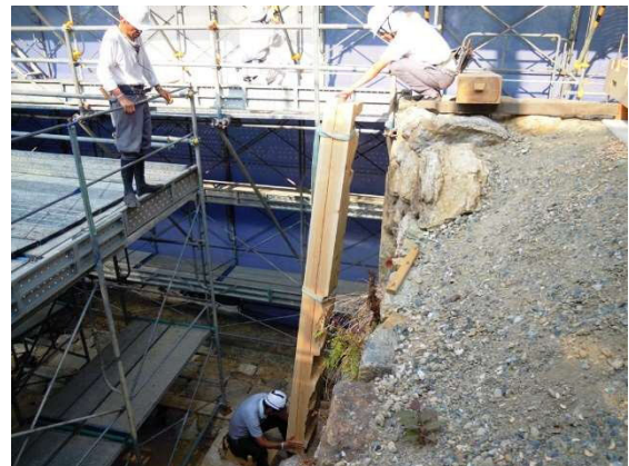
④門の添柱を設置しています。クレーンで吊り込みながら、柱を据えました。
