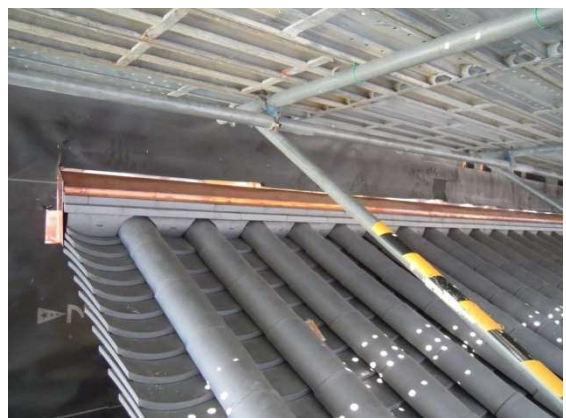
⑥門の庇に瓦が載りました。瓦一枚の三分の二を次の瓦に重ねて葺いています。壁面との取合いに、雨仕舞いの銅板が取り付けられています。
