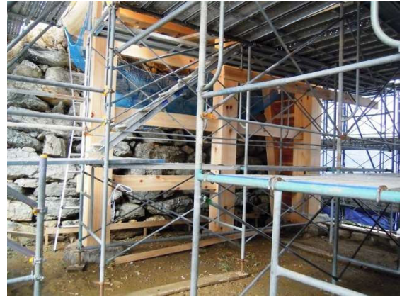
⑧門柱が設置され、3本の通し貫で固められました。
