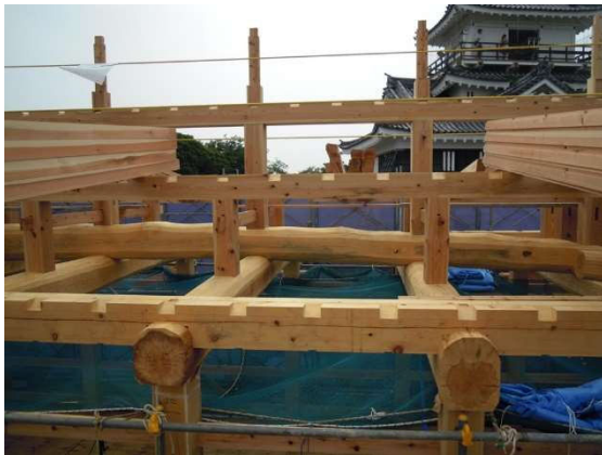
⑬小屋の骨組みです。梁、軒桁、小屋束が設置されています。上部に突き出ているのが、大棟の骨格となる束柱です。
