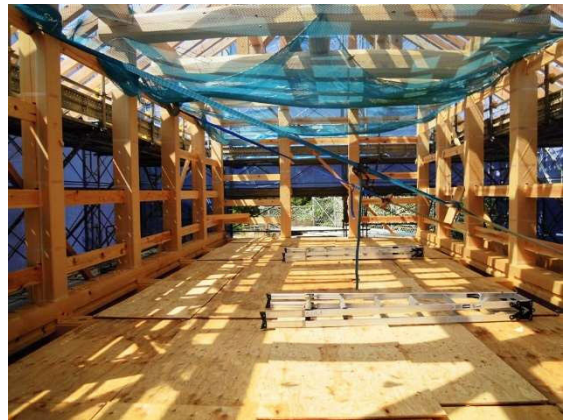
⑭檜の24cm角の柱が18本立ちました。横方向に貫が取り付けられています。
