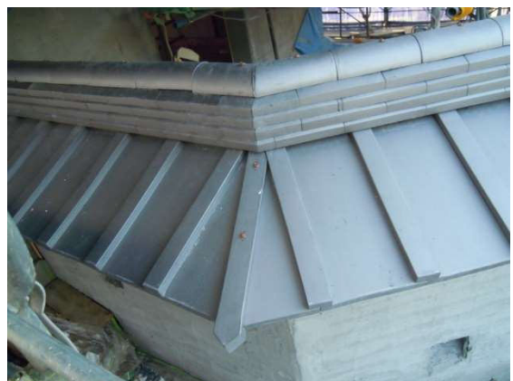
⑥塀瓦は、浜松城内でみつかった瓦片をもとに復元しました。
